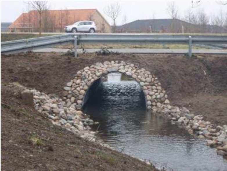
Fig. 3: Fladbundet falsrør (stålrør) (efter Viacon).
