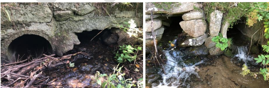
Figur 5; Billeder af overkørslen ved Østergade/Kollerupvej. Indløb til venstre og udløb til højre.
