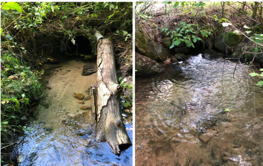
Figur 7; Overkørslen v Ødumvej 3. Indløb til venstre og udløb til højre.
